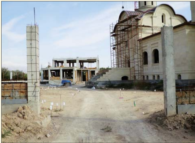
Строительные работы в полном разгаре
